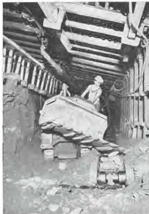
Fig. 8. — Chargeuse sur chenilles à déversement latéral sur un convoyeur à raclettes en action dans la voie de pied d'un chantier d'exploitation; on peut voir aussi :
