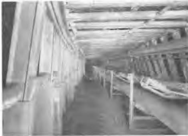
Fig. 30. — Vue d'une voie en creusement à l'aide d'un mineur continu Dosco. On remarque les cadres Usspurwies avec caissons.
