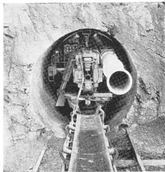
Fig. 6. — Début du creusement d'une galerie de 3 m de diamètre.
