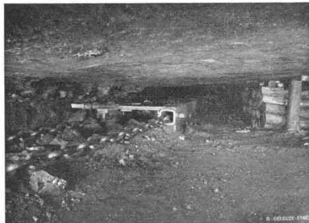
Fig. 4. — Vue du scraper-rabot en taille.
