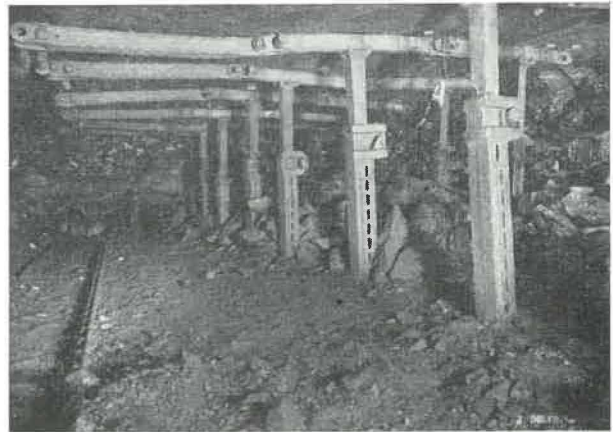
Fig. 8. — Vue montrant la jonction des deux sillons de charbon en taille.
