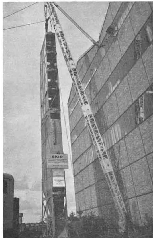
Fig. 10. — Le skip : cuve + cage ; en position de déchargement. Ouverture de chargement (toujours béante) opposée de 180° à la trappe.
