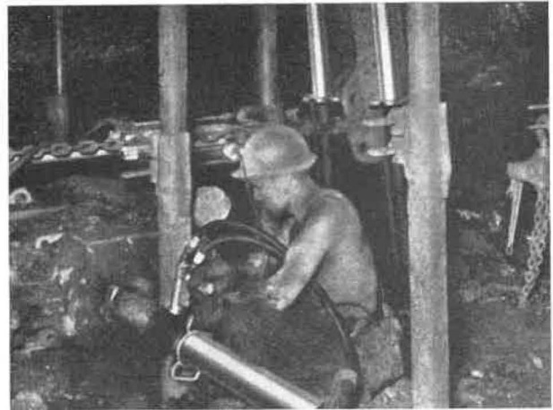
Fig. 11. — Etauçon utilisé pour le ripage d'une tête motrice.
