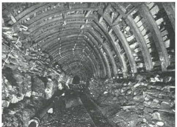
Fig. 7. — Photographie prise dans la même voie, mais dans ce tronçon (C) le front de la voie a été aligné sur le front de la taille. Le revêtement définitif a été placé à 6 m en arrière de la taille. On a pris une basse-taille de 2 m de profondeur et les cadres ont été placés sur de solides piles de bois bourrées de pierres. Vue de la voie 6 mois après le passage de la taille.
