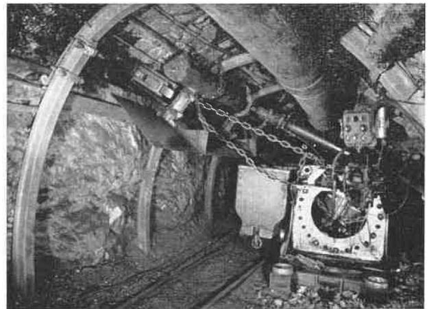
Fig. 1. — Ancien mode de fixation de la chaîne au premier élément du train de bacs.
