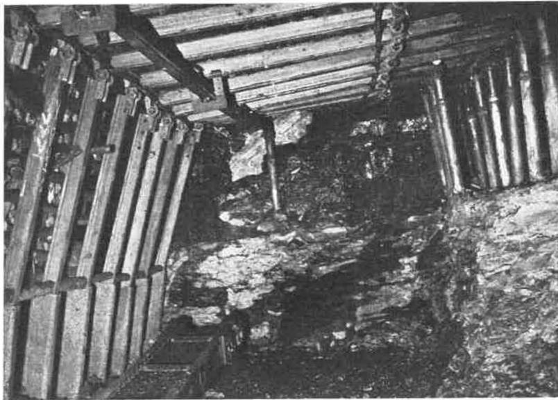
Fig. 10. — Soutènement à front de la voie de pied à la fin du poste de nuit.
