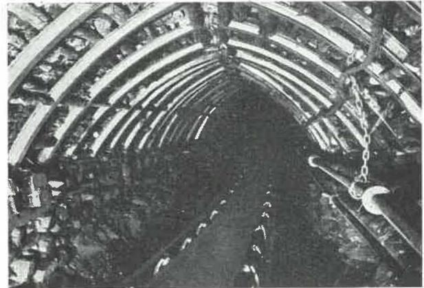
Fig. 10. — Aspect très satisfaisant d'une galerie en cadres articulés sur piles de bois au Charbonnage de Gosson-Kessales, à Liège, à 400 m en arrière du front de taille. Il n'y a eu aucun recarrage, et les terrains sont tendres.
