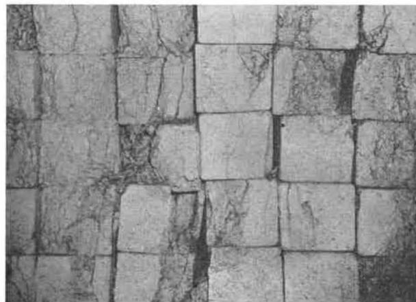
Fig. 8. — Photographie de la paroi du bouveau au milieu de la section sans planchettes intercalaires. Les claveaux sont fracturés et complètement déjetés (charbonnage de Beeringen).
