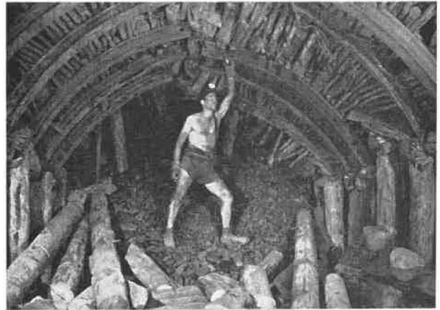
Fig. 14. — Le soutènement de renforcement enlevé, on déboise le fer n° 1, qui est prêt à tomber.
