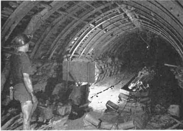
Fig. 12. — Vue d'ensemble de l'installation du a) treuil de déboisage b) skip sur rouleaux de courroie - poulie de retour au toit.
