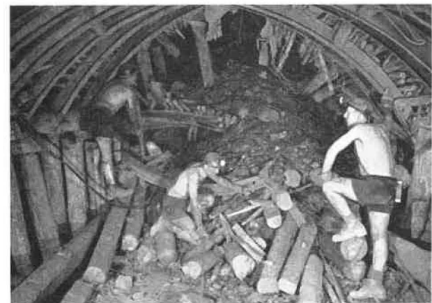
Fig. 16. — Après enlèvement du pilot, la situation est la suivante :
