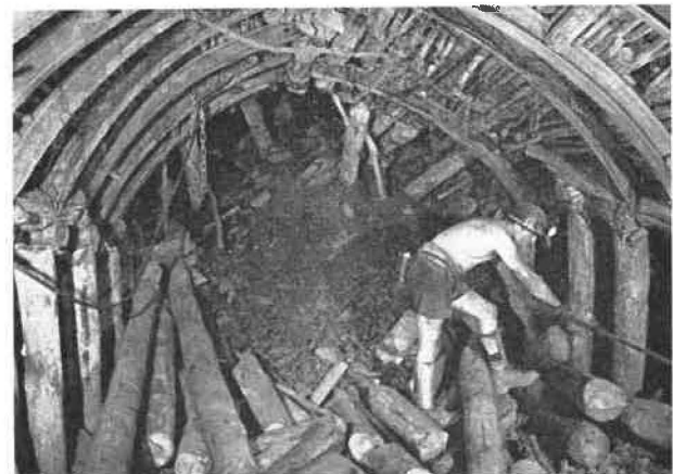
Fig. 15. — En enlevant le fer n° 1, le fer n° 3 est également tombé; ils ont été tous deux retirés vers l'arrière. On enlève le pilot se trouvant sous le fer n° 2 (solution la plus facile).
