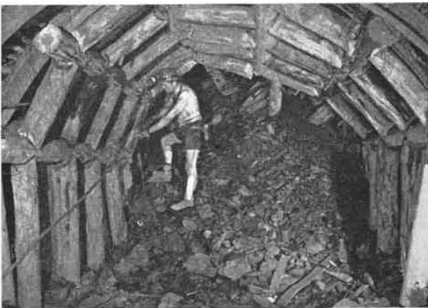
Fig. 13. — Situation au début du déboisage; on déboise le soutènement de renforcement (sans mouflage).
