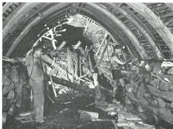
Fig. 10. — Vue générale du front de récupération. a) poulie de déboisage b) élingue d'allonge au deux derniers fers Moll.
