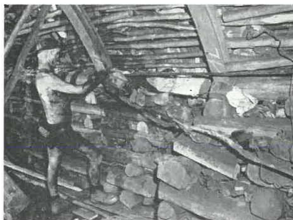
Fig. 11. — Détails : a) extrémité du câble de déboisage - crochet b) élingue d'allonge passant sur la poulie c) entaille de la longrine.
