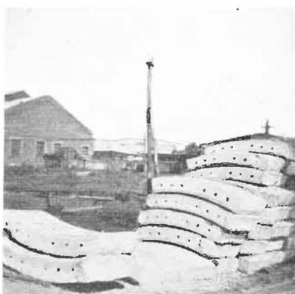
Fig. 23. — Fonçage de puits - Claveaux à placer en descendant.
