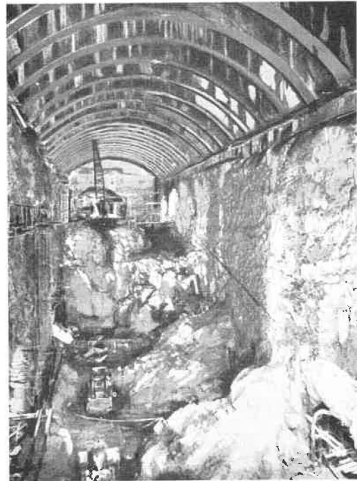
Fig. 34. — Fin du creusement de la salle des machines.
