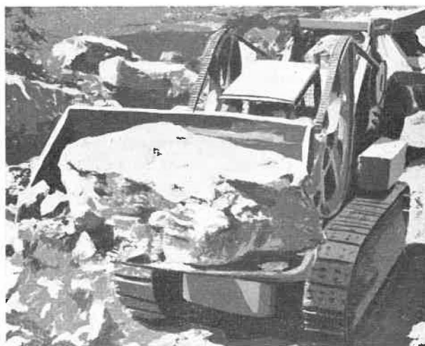
Fig. 31. — Chargeuse montée sur chenilles avec godet d'une capacité de 1.350 litres.
