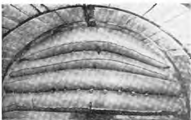
Fig. 36. — Barrage formé de coussins gonflables superposés.
