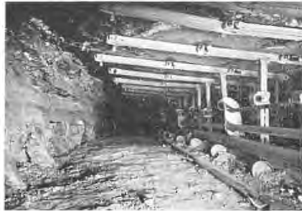
Fig. 6. — Vue de la taille avant ripage du transporteur-freineur. A l'avant plan, on aperçoit les tubes de 2" de diamètre et de 1,20 m de longueur qui permettent le ripage aisé des couloirs sur le mur de la veine.
