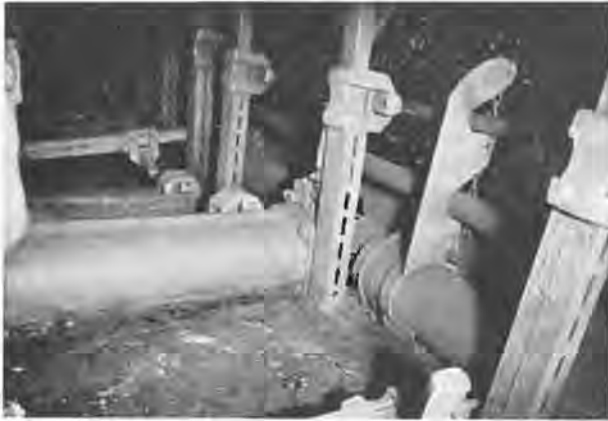
Fig. 11. — Allée de circulation derrière le freineur et cylindre pousseur utilisé au ripage de l'installation. On remarque également les supports de tuyauterie.
