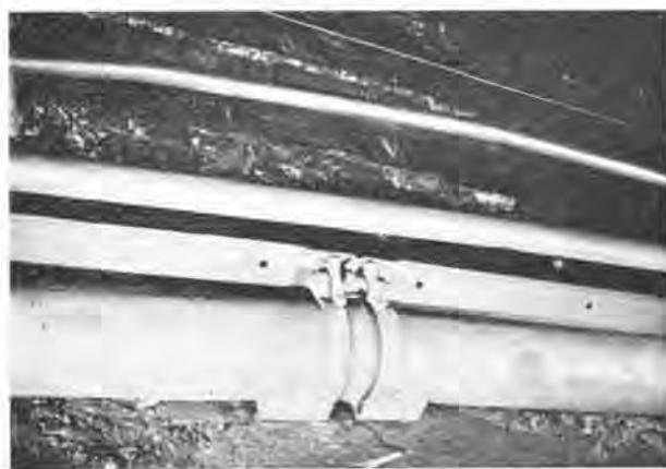
Fig. 9. — Vue montrant une jonction de couloirs du freineur en taille.
