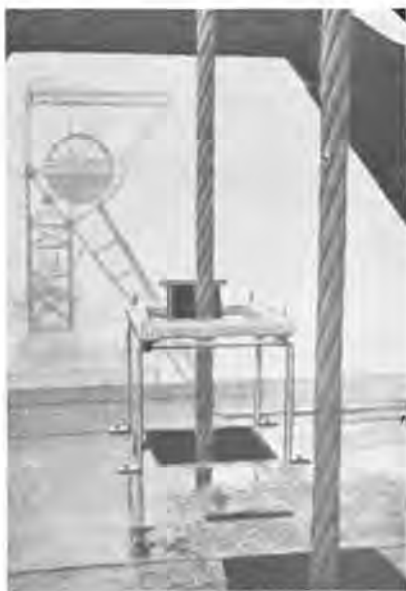
Fig. 28. — Disposition du transformateur sous la molette.
