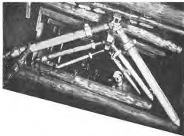
Fig. 5. — Soutènement en K, Bécorit pour dressants.
