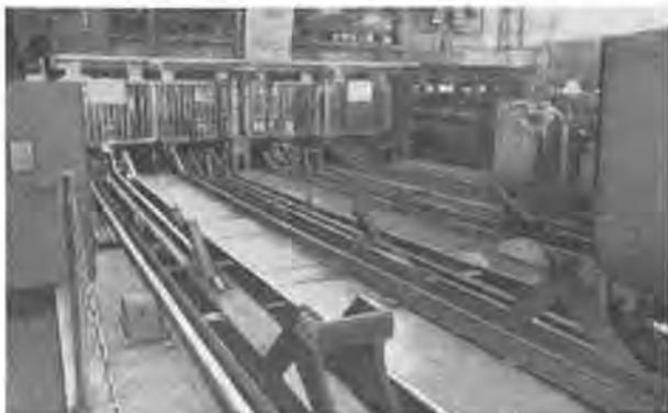
Fig. 5. — Dispositif d'éclusage des berlines par arrêt sur les butoirs.
