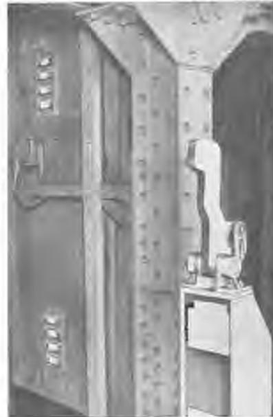
Fig. 8. — Position des aimants sur la paroi latérale de la cage et de l'interrupteur sur les supports du guidonage.
