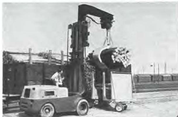
Fig. 22. — Lève-truck pour la manutention des bois en surface (Esslingen).
