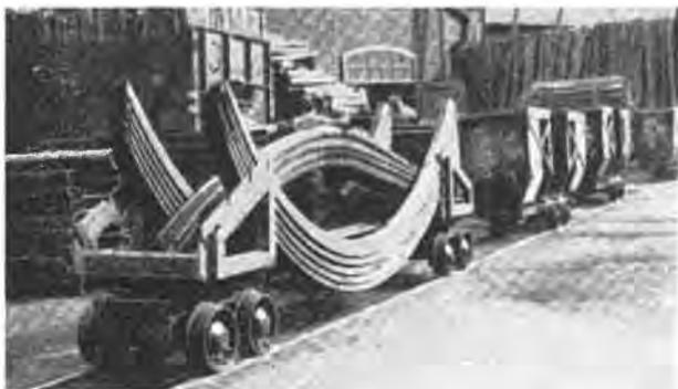
Fig. 5. — Truck pour le transport des éléments de cadre.
