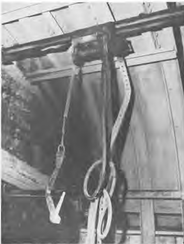
Fig. 4. — Monorail de déchargement des claveaux.
