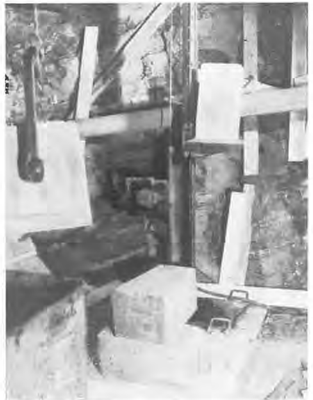
Fig. 15. — Manutention des claveaux à l'élévateur.
