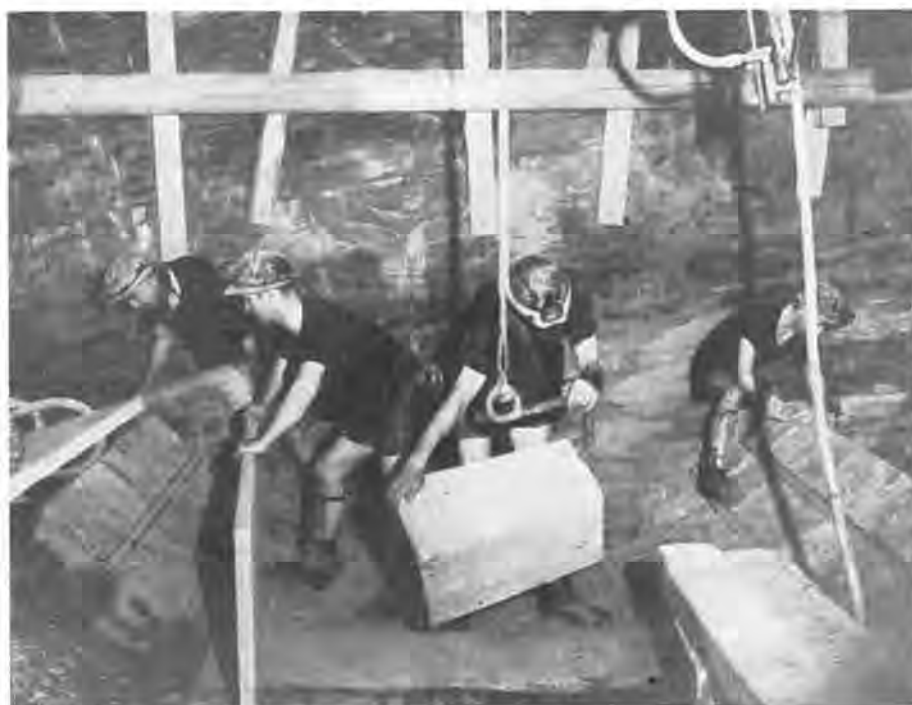
Fig. 13. — Pose des claveaux du radier.
