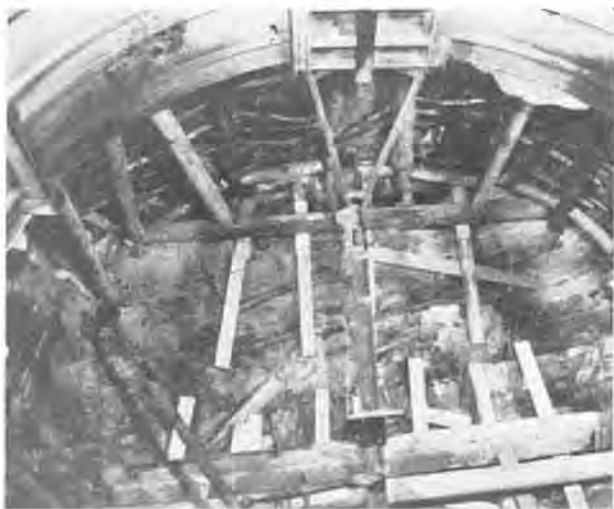
Fig. 2. — Vue du boisage provisoire.
