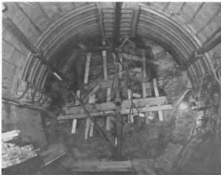
Fig. 3. — Vue d'ensemble du front de creusement du bouveau.
