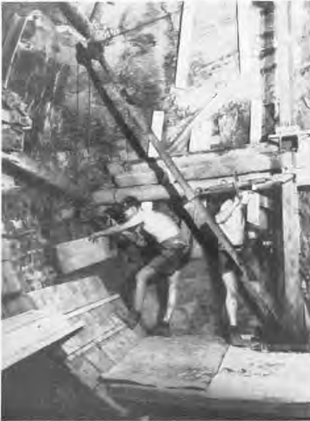
Fig. 14. — Pose des claveaux des parois.
