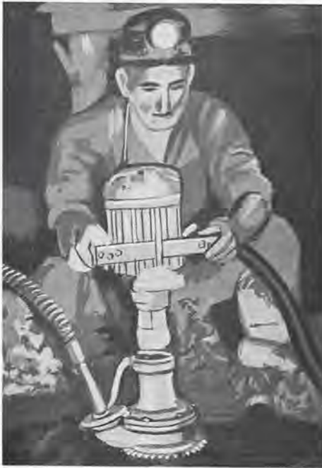
Fig. 28. — Pompe portative Blagdon-Durham actionnée par un moteur de perforatrice Victor.
