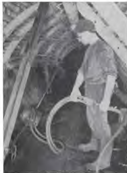
Fig. 58. — Palan à air comprimé Hedef utilisé au désameublément d'une voie.
