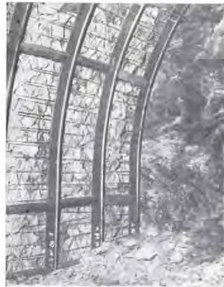
Fig. 8. — Galerie équipée d'un garnissage métallique Löbbert.
