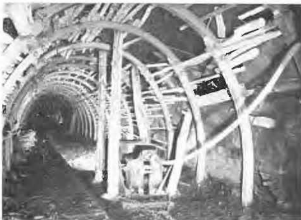
Fig. 7. — Treuil de ripage de la tête motrice de tête, il est placé 25 m en avant du front de taille.
