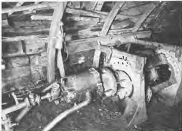
Fig. 3. — Tête motrice de tête, la poutrelle d'appui sur le cadre à une longueur de 2,50 m; les fers U reliant cette poutrelle au bâti ont été allongés.
