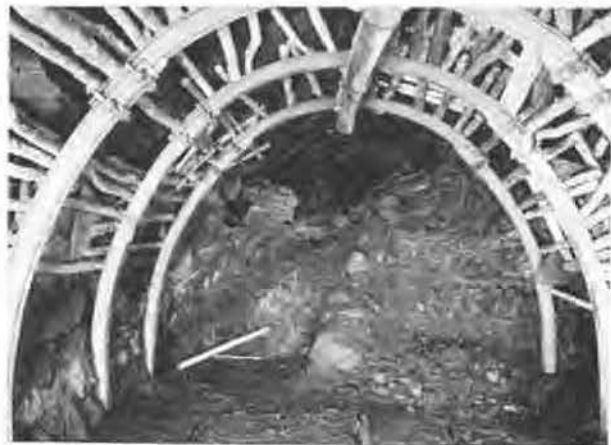
Fig. 10. — Recarrage de la voie de tête, la veine se trouve dans le coin inférieur gauche de la photo.
