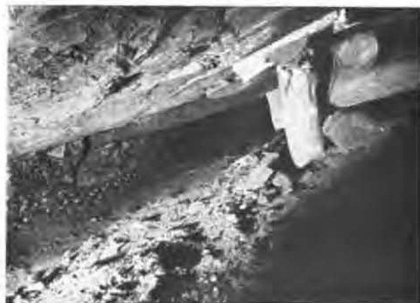
Fig. 16. — Partie supérieure de la taille; on distingue nettement l'ennoyage des fronts.
