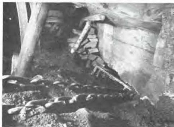
Fig. 13. — Caisse de Scraper transformée, photo prise à l'entrée de la taille; les tubes de guidage du brin de retour de la chaîne se trouvent contre le front de taille.
