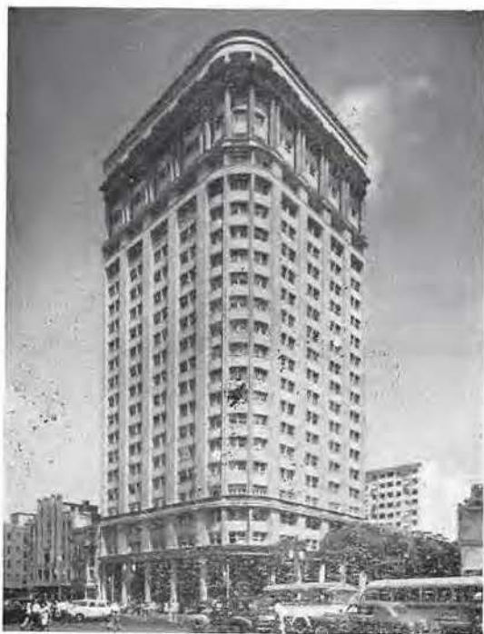
Edificio Albacap à Rio de Janeiro (Brésil) 216 Pieux Franki.
