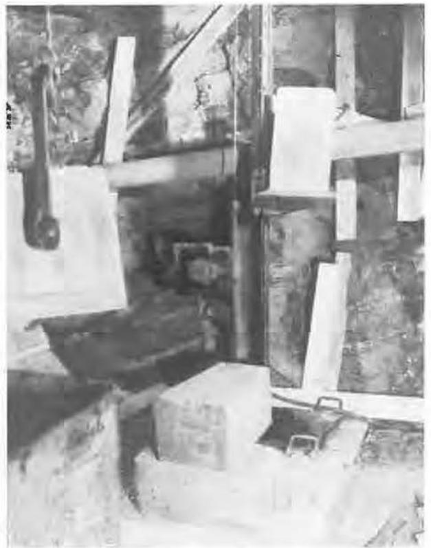
Fig. 15. — Manutention des claveaux à l'élévateur.
