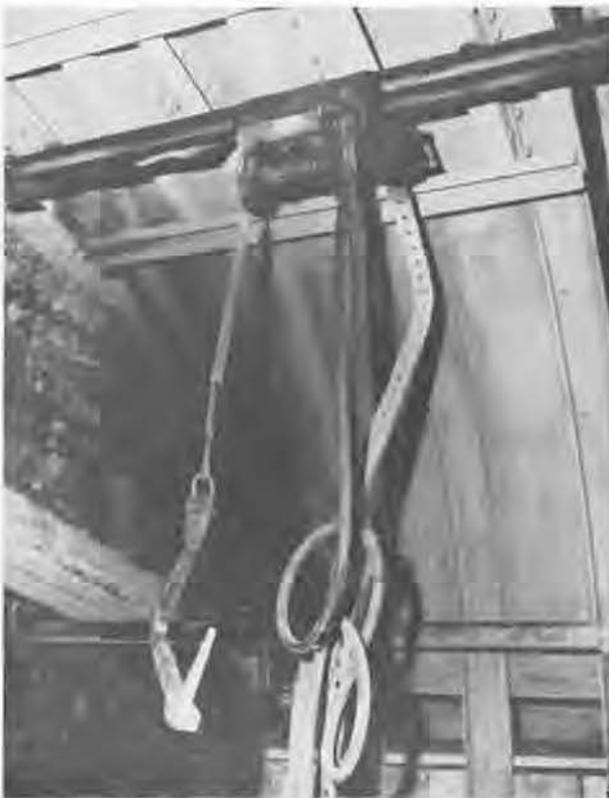
Fig. 4. — Monorail de déchargement des claveaux.
