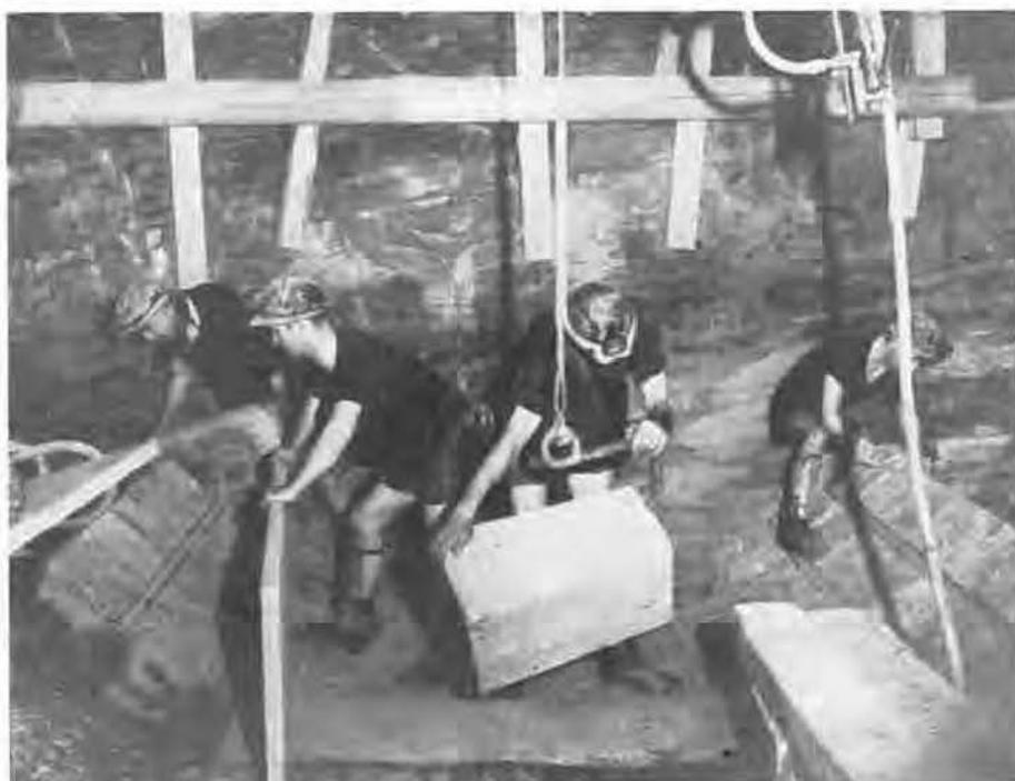
Fig. 13. — Pose des claveaux du radier.
