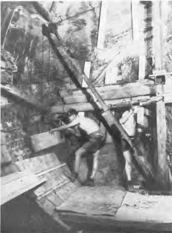
Fig. 14. — Pose des claveaux des parois.
