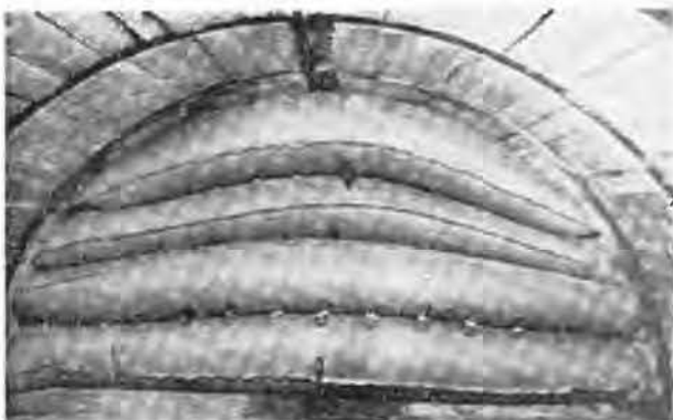
Fig. 36. — Barrage formé de coussins gonflables superposés.
