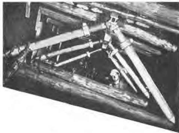
Fig. 5. — Soutènement en K, Bécorit pour dressants.
