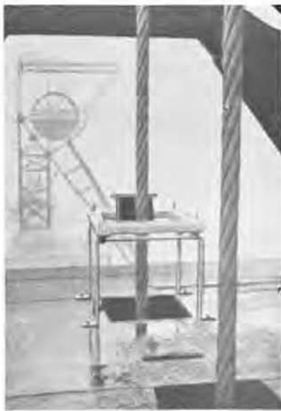
Fig. 28. — Disposition du transformateur sous la molette.
