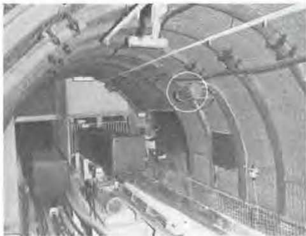
Fig. 34. — Montage d'une camera de télévision dans un accrochage.
