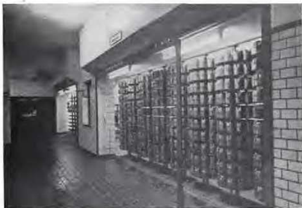
Fig. 43. — Distribution des filtres à CO 2 , type « Selbretter » à serrure magnétique soudée.
