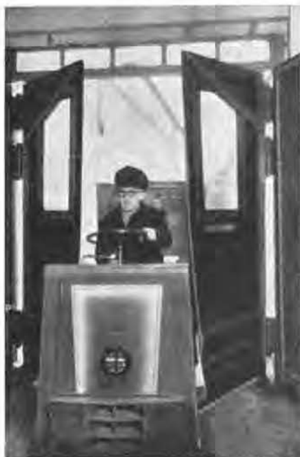
Fig. 23. — Portes en caoutchouc s'ouvrant sous la poussée des trucks.
