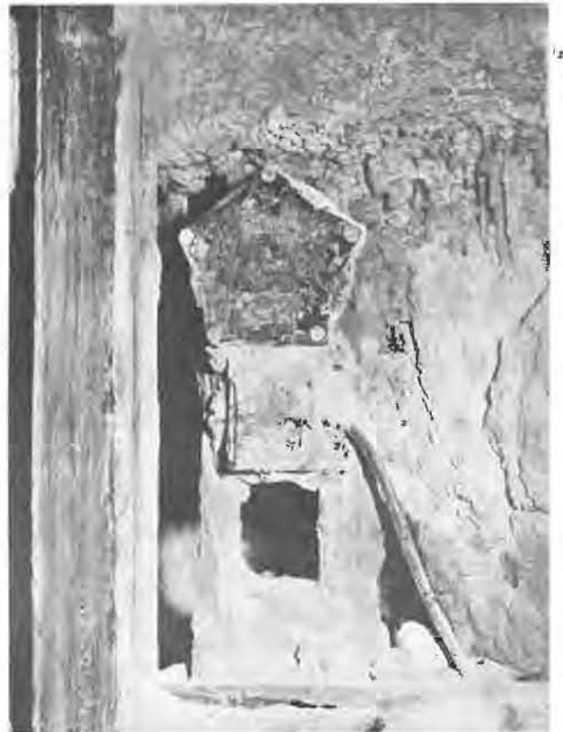
Fig. 12. — Vue d'un interrupteur magnétique placé à proximité du guidonage.
