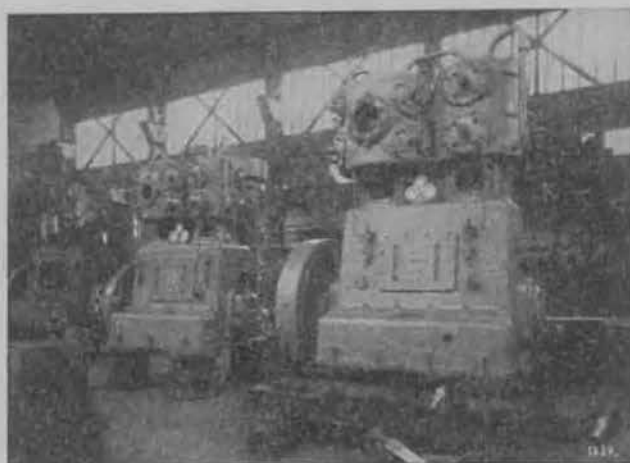
Compresseurs d'air 40 et 80 m 3 /min. - Pression 8 kg/cm 2 .
