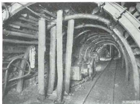
Fig. 11. — Abattage par scie Neuenburg. Vue d'ensemble de l'installation dans la galerie de retour d'air.
