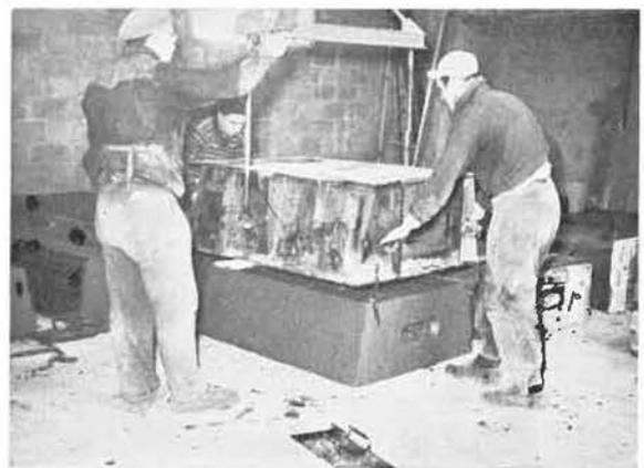
Fig. 28. — Démoulage d'un clavier.
