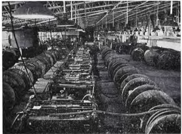
Fig. 4. — Vue générale de la section d'entretien des câbles électriques.
