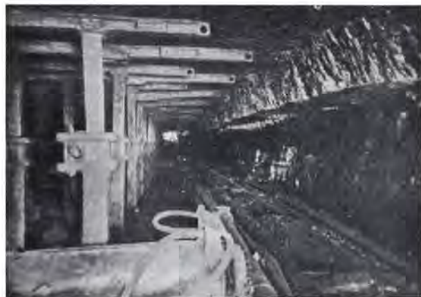
Fig. 6. — Ripage du convoyeur après passage de la haveuse dans les deux sens (après les phases d'abatage et de nettoyage).
