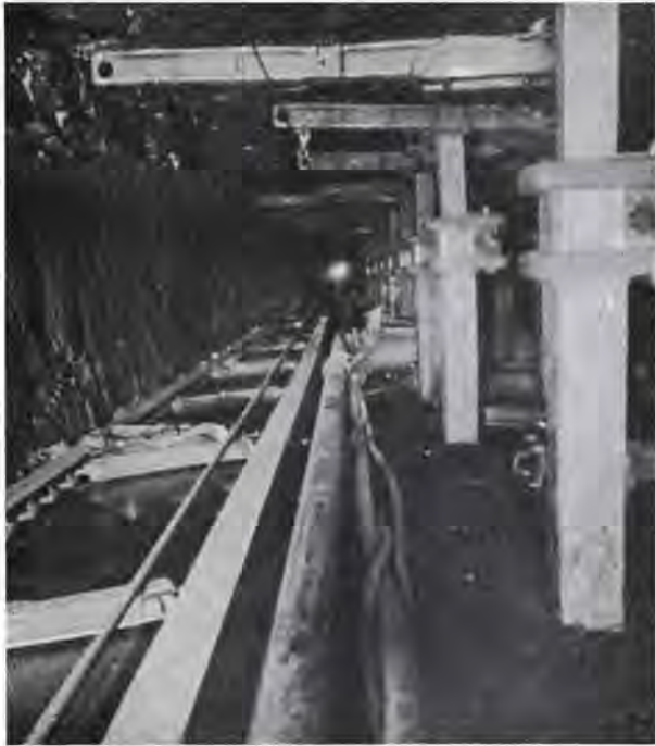
Fig. 7. — Front de taille prêt au lavage (les derniers étançons le long du convoyeur n'ont pas encore été posés).
