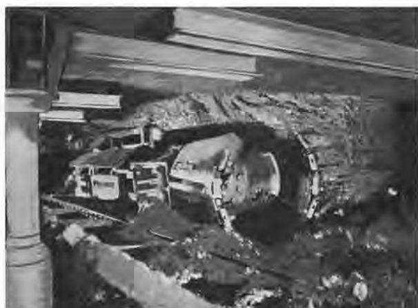
Fig. 5. — Trepanner en action dans la couche « Low Main ».
