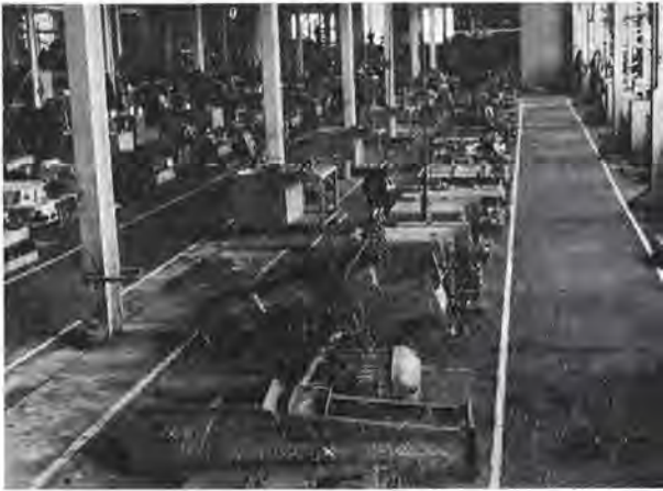
Fig. 6. — Vue de la section « entretien des engins de tailles ».
