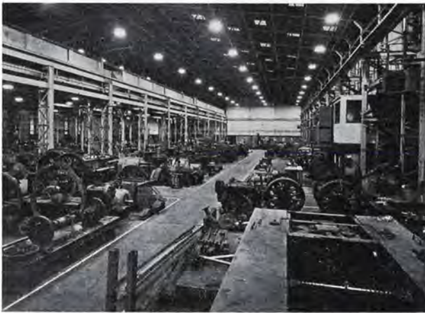
Fig. 2. — Vue de la section de mécanique générale (démontage et entretien des engins du fond).
