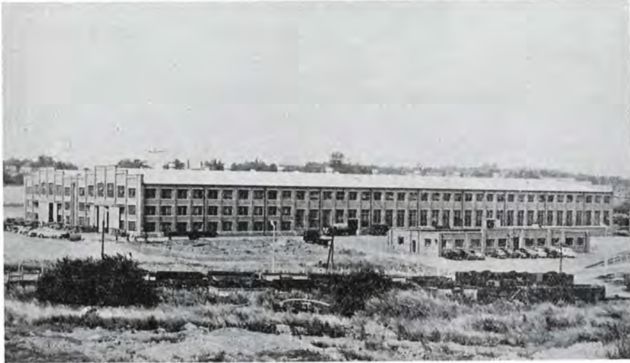
Fig. 1. — Vue d'ensemble de l'atelier central.
