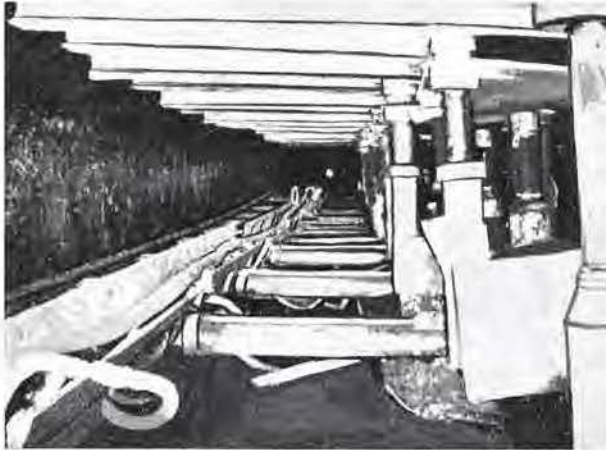
Fig. 8. — Architecture du soutènement. Actuellement le soutènement de la taille est renforcé par une file d'étauçons hydrauliques Dowty disposés le long du convoyeur (en face le convoyeur et les piles). Ces étauçons ne sont pas visibles sur la photographie.
