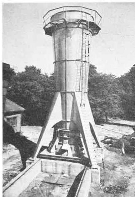
Fig. 18. — Ventilateur type hélicoïde à axe vertical — Brevet Berry.
