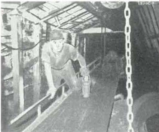
Fig. 17. — Installation de mains courantes le long du transporteur.
