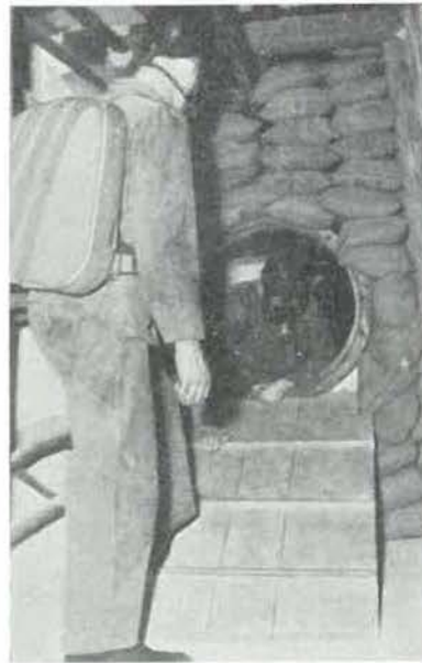
Fig. 65. — Sauveteurs à l'exercice traversant un tuyau disposé dans un barrage.
