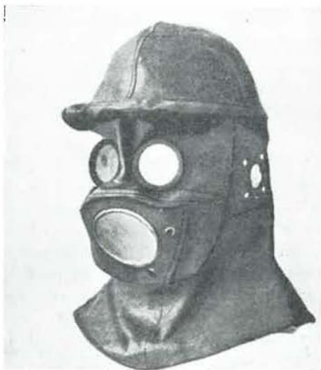
Fig. 38. — Capuchon ignifuge permettant de porter une casquette et double tamis pour la respiration.
