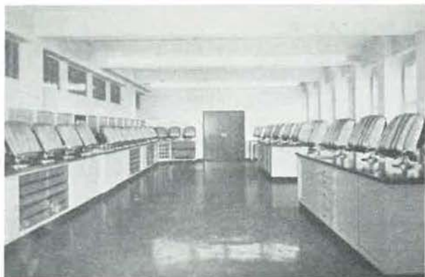
Fig. 59. — Grande salle d'appareils de la Centrale de sauvetage d'Essen.
