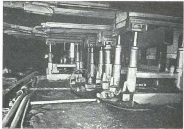
Fig. 4. — Soutènement marchant type « Seaman Gullick ».
