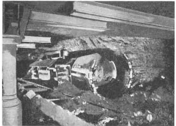
Fig. 5. — Trepanner en action dans la couche « Low Main ».
