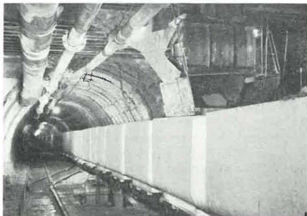
Fig. 16. — Point de chargement central et berlines de 3.500 litres.
