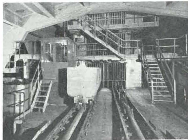
Fig. 18. — Nouvelle recette de surface au siège Penzberg. On remarque également les postes de commande surélevés de l'encageur et du préposé à la manœuvre des aiguillages et du culbuteur.
