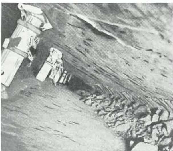
Fig. 7. — Treillis métallique pour le transport du charbon dans la couche « Sarnsbank » de 0,45 m de puissance, inclinée à 60^\circ . Le treillis est placé parallèlement au talus des remblais.
