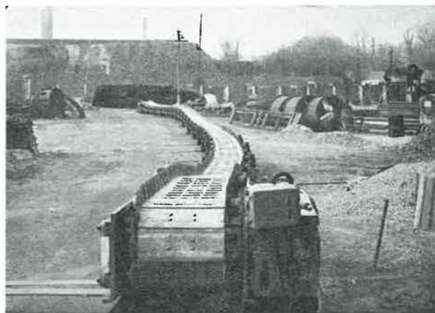
Fig. 28. — Convoyeur à écailles Génard-Denisty.
