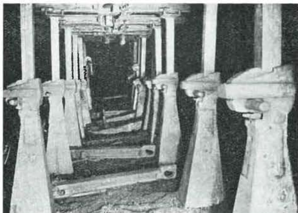
Fig. 21. — Etançon à base élargie en taille.
