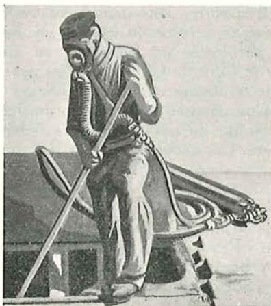
Fig. 57. — Masque relié par flexible à une bonbonne à air ou oxygène comprimé (Auer et Dräger).
