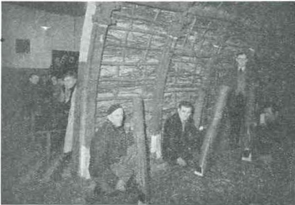
Au Centre d'apprentissage, la salle de cours et la voie de base du chantier-école.
