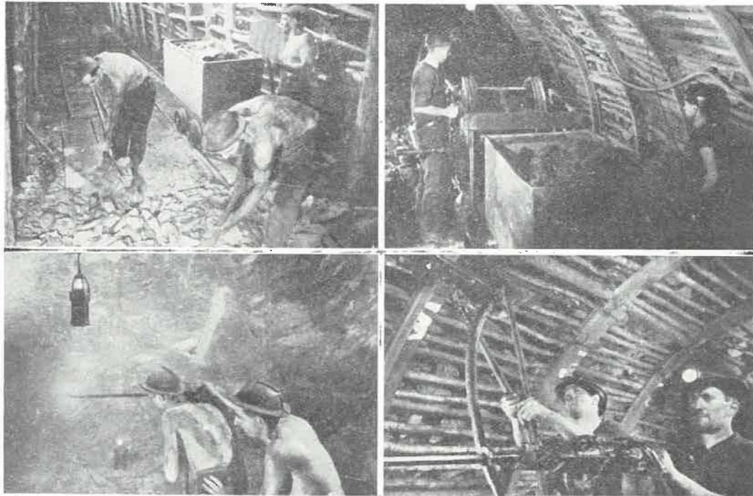
La foration des trous de mines...
