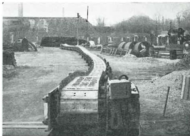
Fig. 28. — Convoyeur à écailles Génard-Denisty.
