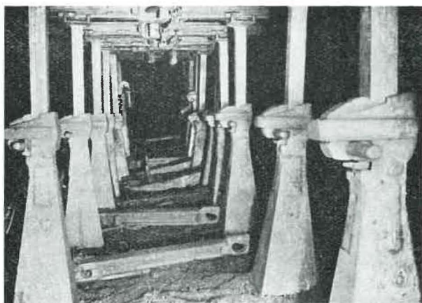
Fig. 21. — Etançon à base élargie en taille.
