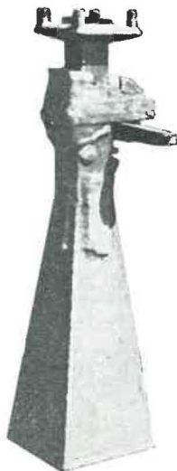
Fig. 20. — Etançon à base élargie.
