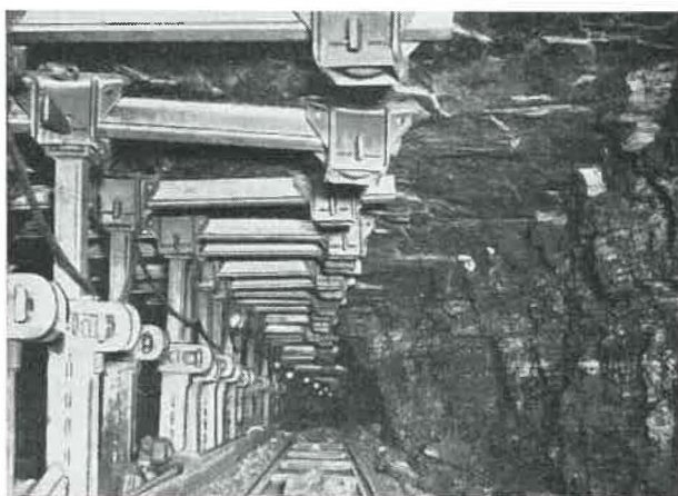
Fig. 10. — Taille à front dégagé avec têtes Buschmann et bèles en aluminium.
