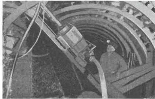
Fig. 44. — Foreuse double installée dans une galerie.
