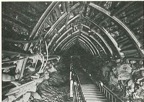
Fig. 35. — Couche Stenaye - Profondeur 1050 m - Convoyeur à écailles dans la voie de base.
