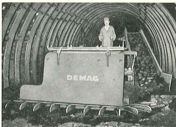
Fig. 136. — Chargeuse à palettes mobiles Demag.
