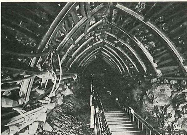
Fig. 12. — Convoyeur métallique à écailles dans une voie de chantier.
