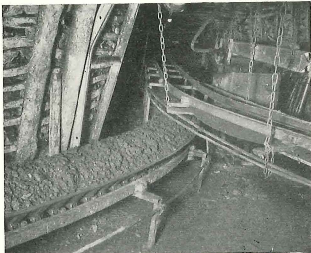
Fig. 117. — Franchissement d'une courbe par le train-navette de Hemscheidt.
