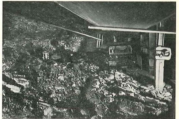
Fig. 33. — Couche Malgarnie - Profondeur 980 m - Vue de la préparation du charbon après passage de la haveuse.
