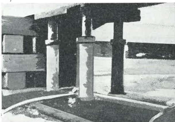
Fig. 51. — Construction de la pile hydraulique à avancement automatique Seaman.
