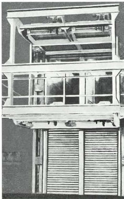
Fig. 14. — Vue d'ensemble des volets étanches Hasenclever pour puits de retour d'air.
