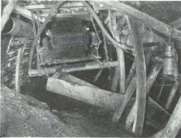
Fig. 43. — Amenée des remblais en tête de taille par convoyeur métallique.
