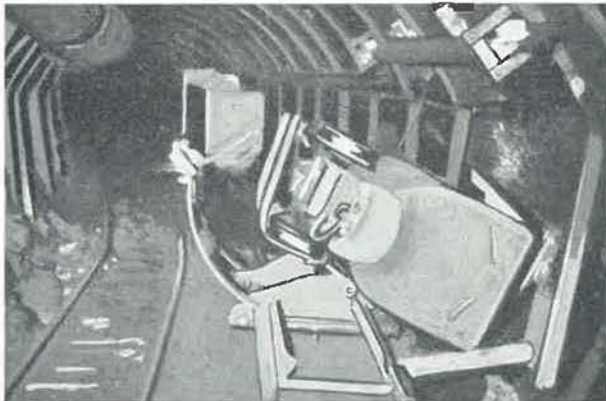
Fig. 12. — Berline culbutée avec culbuteur Hauhinco.
