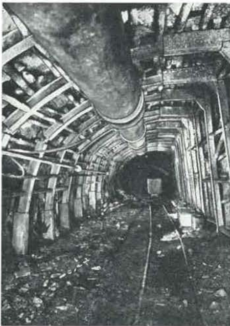
Fig. 76. — Soutènement en cadres Usspurwies appliqué à une voie d'exploitation en dressant.
