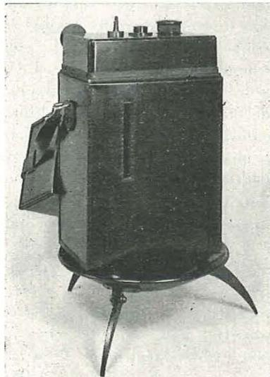
Fig. 40. — Trépied spécial pour mise en station du microbaromètre Askania.
