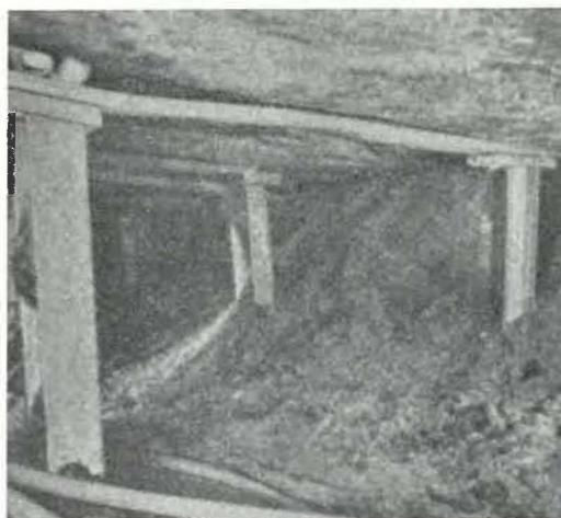
Fig. 2. — Remblai effectué par le Gum-Flinger.
