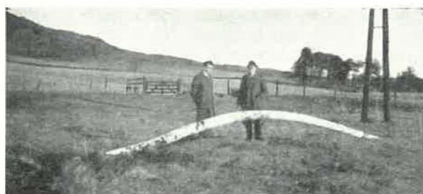
Fig. 11. — Importantes conduites à gaz en acier poussées hors du sol par compression horizontale.
