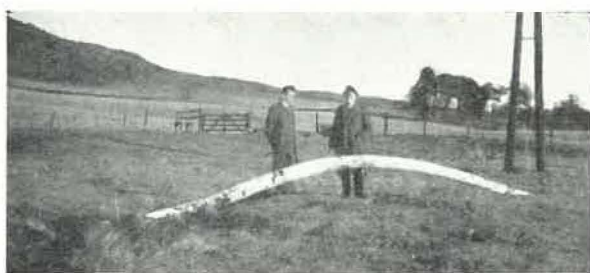
Fig. 11. — Importantes conduites à gaz en acier poussées hors du sol par compression horizontale.
