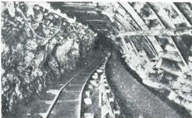
Fig. 21. — Vue du convoyeur curviligne sur rails dans une voie d'exploitation.
